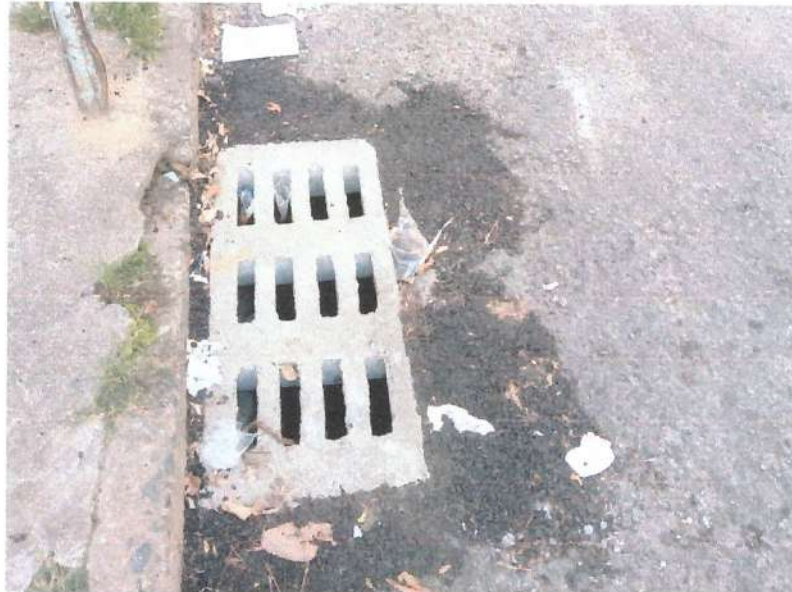
Figura 02 – Situação da amostra de grelha instalada na Rua Espírito Santo, Bairro da Pituba, em 22/01/2024.
